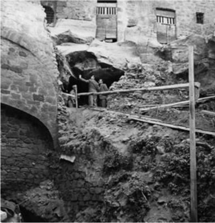
L'immagine mostra l'entità e pericolosità della frana del 18 marzo 1956, aggravata dalla presenza di cavità che solo di recente sono state censite e, dove necessario, riempite, per garantire stabilità al masso tufaceo sul quale insiste l'abitato. Nella foto si notano tecnici e funzionari del Genio Civile, accompagnati dalle maestranze, ispezionare il luogo per gli interventi del caso (ASV, fondo Genio Civile, b. 1391)
