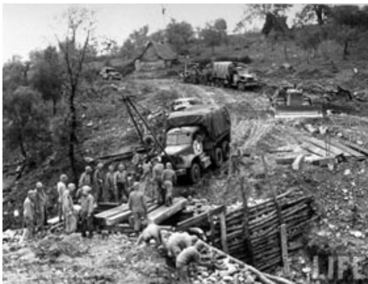
Campagna d'Italia 1944. Genieri americani ripristinano un ponte per consentire il transito di uomini e mezzi
