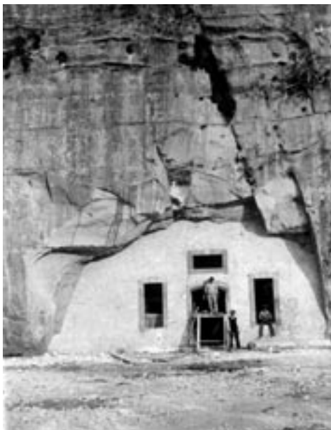
Libia 1912-13, polveriera in costruzione. Si notino gli operai civili addetti ai lavori. E' tra simili maestranze, appunto, che poteva figurare il muratore piansanese Adriano Bronzetti
